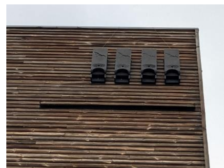
Figure 15 : Gîte de la résidence Métronome avec un gîte interne et 4 gîtes Schwegler 1FFH
