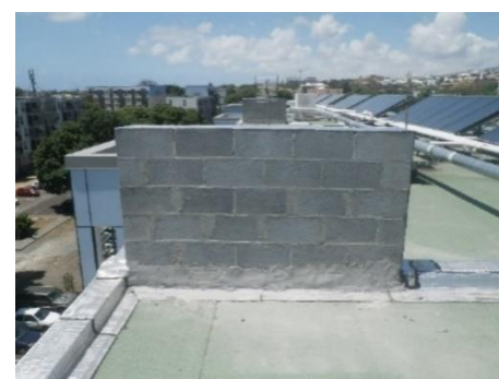
Figure 12 : Gîte artisanal en béton de type « sandwich de pierre » - Résidence Camélia Château Morange à Saint-Denis
